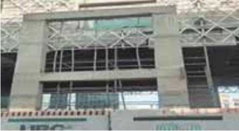
20 मीटर लंबा एफओबी – यह एफओबी करीब 20 मीटर लंबा है, जो एफओबी जीजी फ्लाईओवर से डेढ़ मीटर नीचे और सड़क से करीब 7 मीटर ऊपर बनाया जा रहा है। यानी, एफओबी के ऊपर-नीचे से गाड़ियां गुजरेंगी। मेट्रो स्टेशन की एंट्री-एग्जिट बनाने
